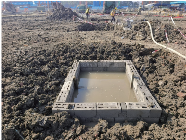
>图2 泥浆循环池砌筑
