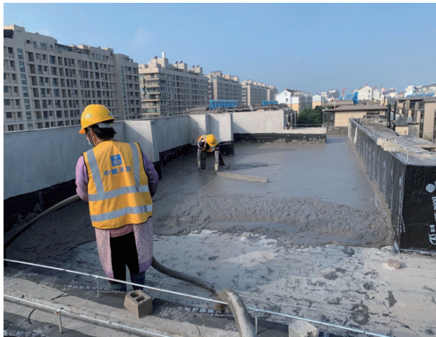
>图3 屋面发泡混凝土施工
