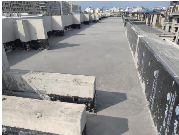
>图4 泡沫混凝土自然养护
