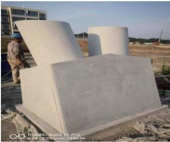
> 图1：冷却塔支墩及人字柱
