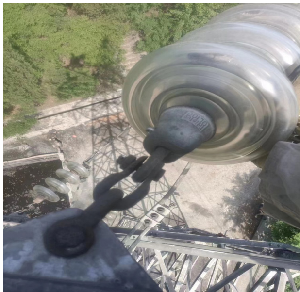
图 7 某线路耐张塔销子脱落
