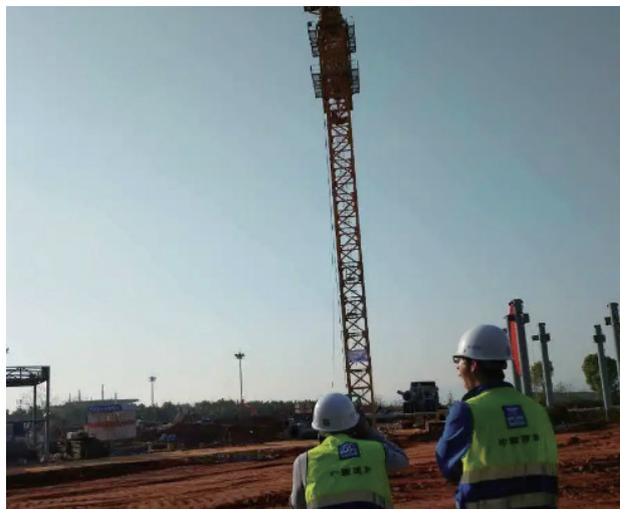
>图1 塔吊检测
