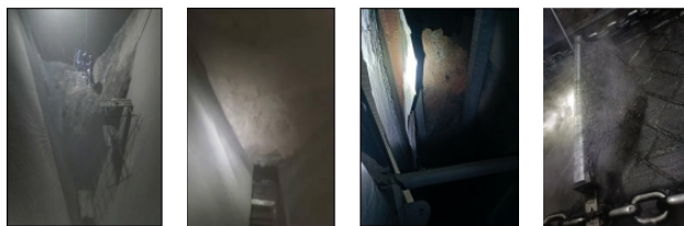
#1 炉左侧 9.3 米人孔处
