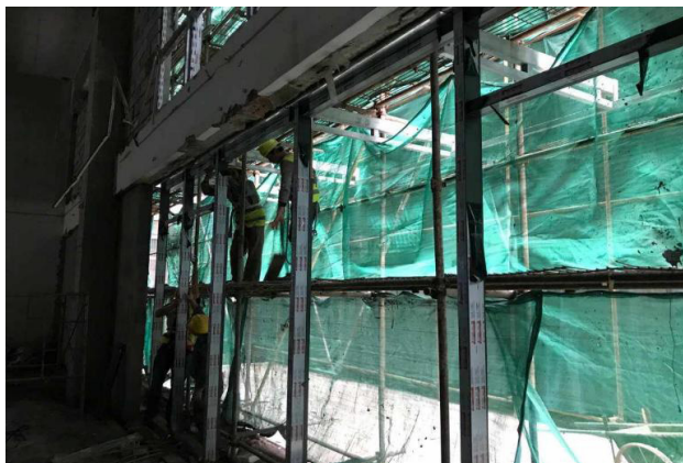
图1：幕墙立柱龙骨安装图
