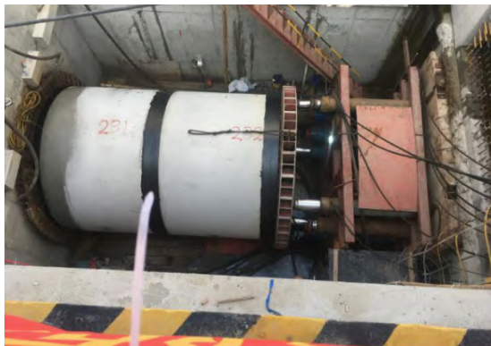
>图1 DN4000泥水平衡顶管机
