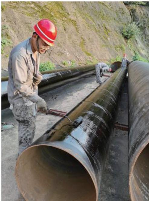
图1 管道防腐、防渗涂抹施工
