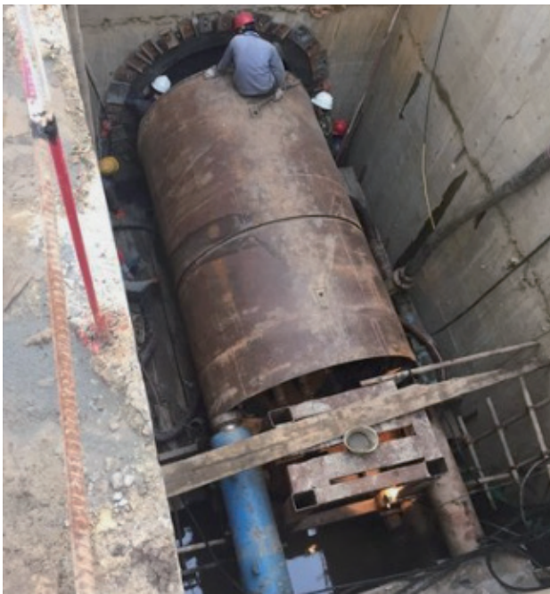
图1 泥水平衡法顶管施工
