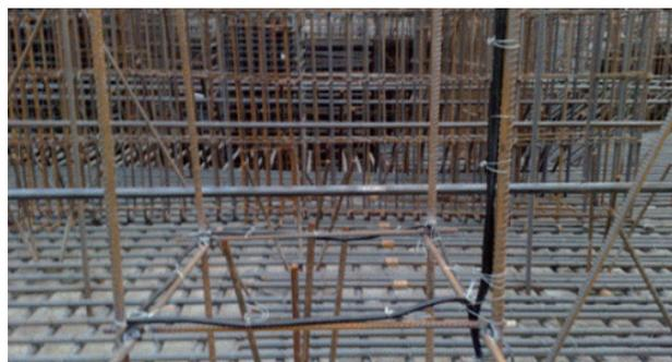
>图1 大体积混凝土循环水降温管及测温光纤
