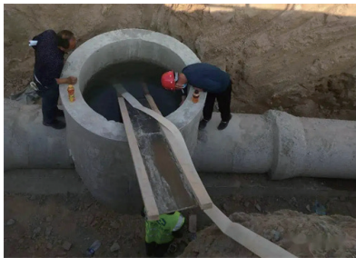
>图2 闭水试验
