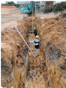
>图1 沟槽开挖技术
