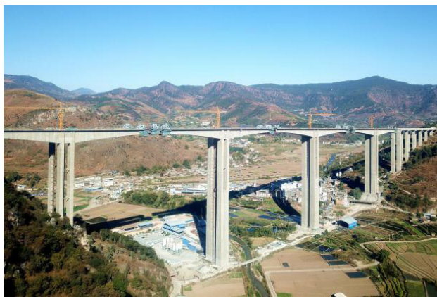
图4 云南新庄大桥远景
