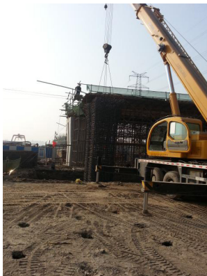
>图1 钢筋骨架整体吊装
