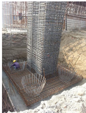
>图2 连接承台底层水平主筋
