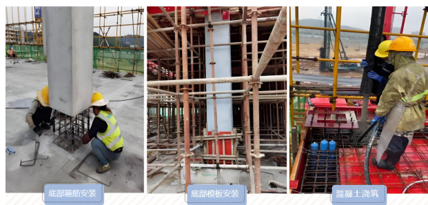
> 图2 预制空腔柱施工流程
