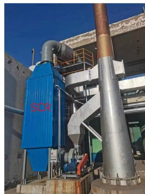
图3 SCR脱硝系统的安装
