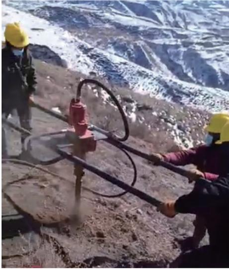
图5 “小蜜蜂”潜孔钻机人工成孔图
