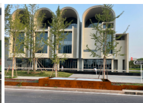
图8 管廊通风口改造后
