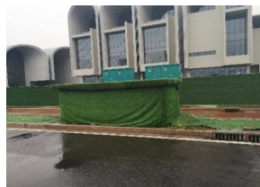
图7 管廊通风口改造前
