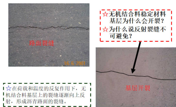
图1 反射裂缝
