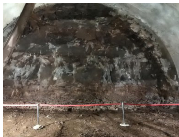
图10 光爆后排险后无超欠挖
