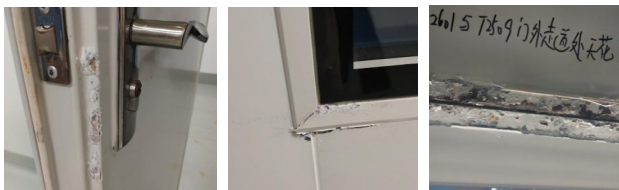
图 1-3 门框的腐蚀迹象
