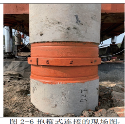
图 2-6 抱箍式连接的现场图
