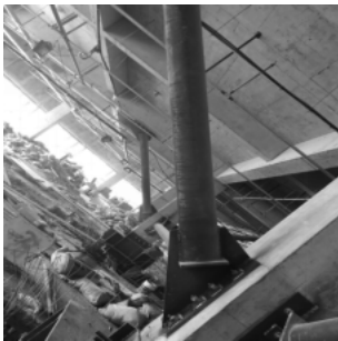
图11 斜拉杆与二层混凝土柱连接节点
