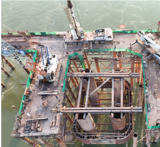
图3 吊挂系统及围堰下放
