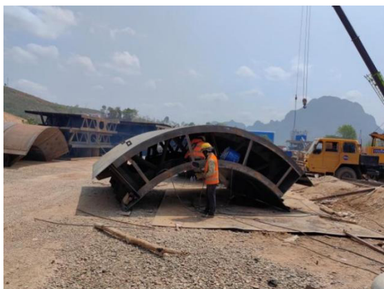
图2 钢围堰加工块段
