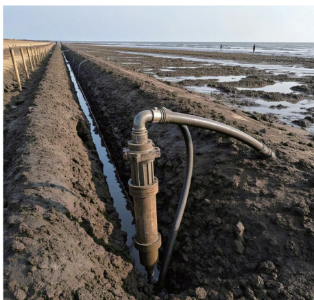
图1 花管注浆加固滨海软土路基图
