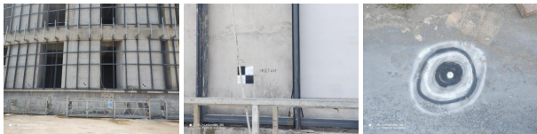
图四（4）：现场建筑物十字定位
